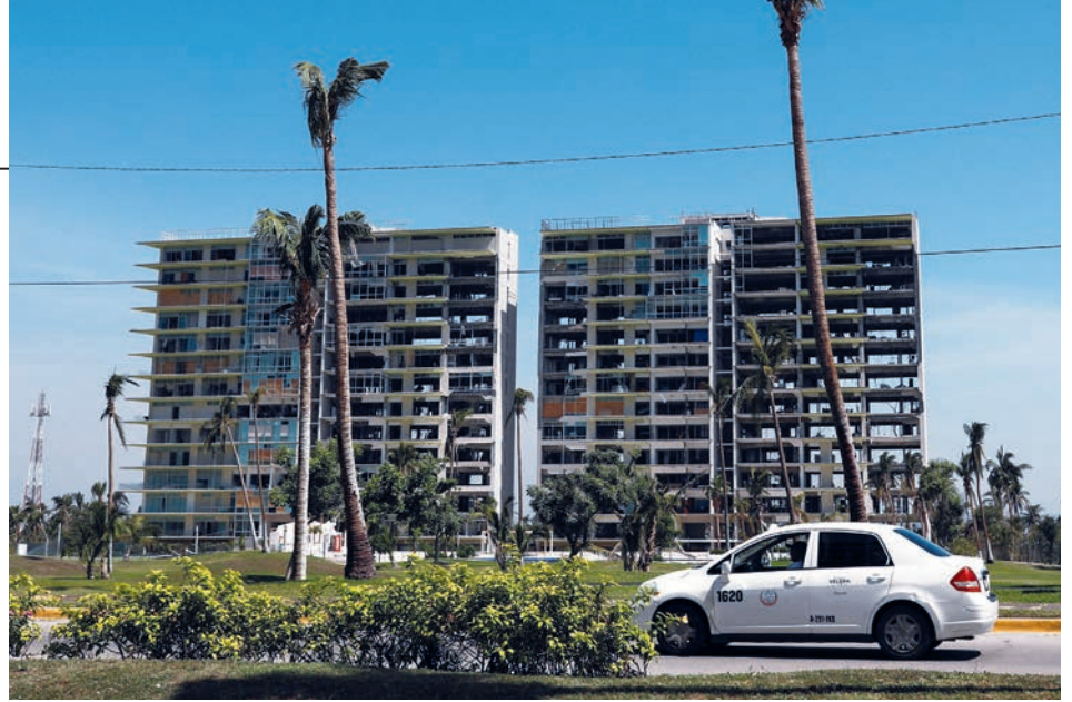
● Edificios dañados por Otis en la zona Diamante de Acapulco.
