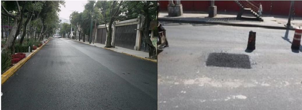
Repavimentación y Bacheo
